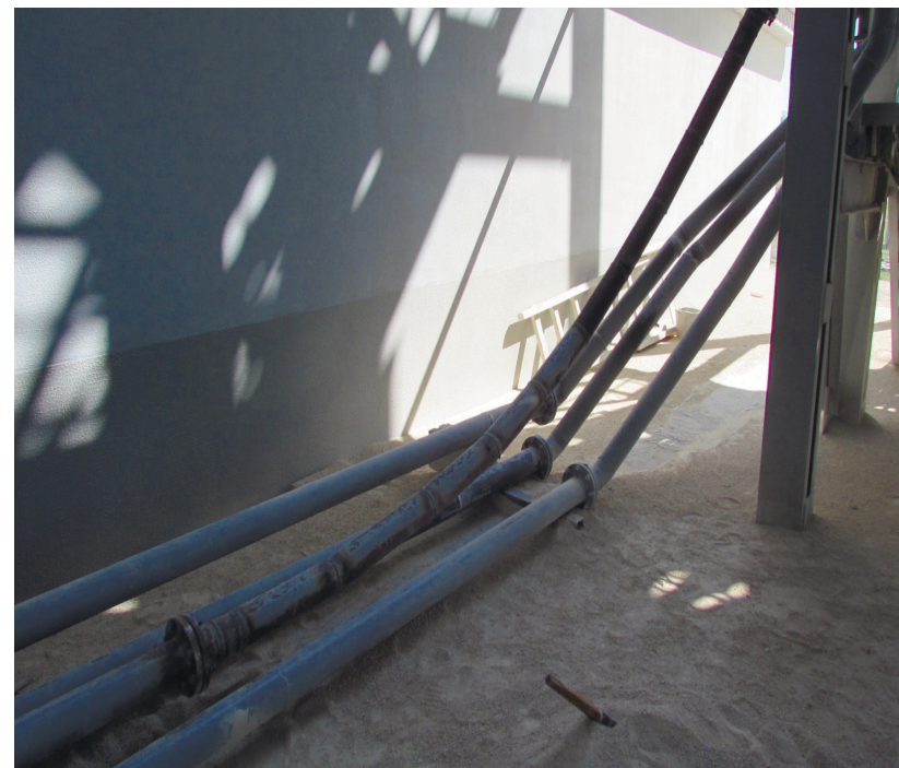
Пример плавного поворота на фоне неправильной прокладки пневмотрассы без проведения проектных работ
